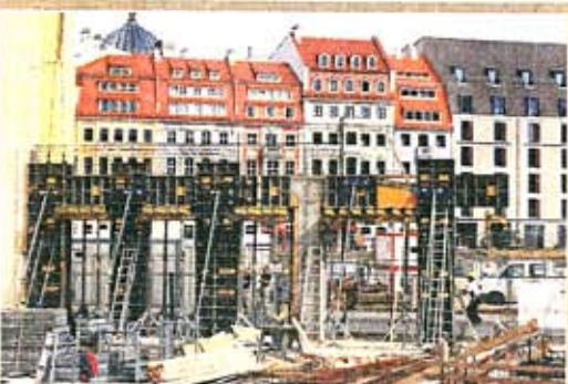
Am British Hotel werden die ersten Fassadenteile des Erdgeschosses betoniert. Bis Ostern 2010 soll alles fertig sein.
